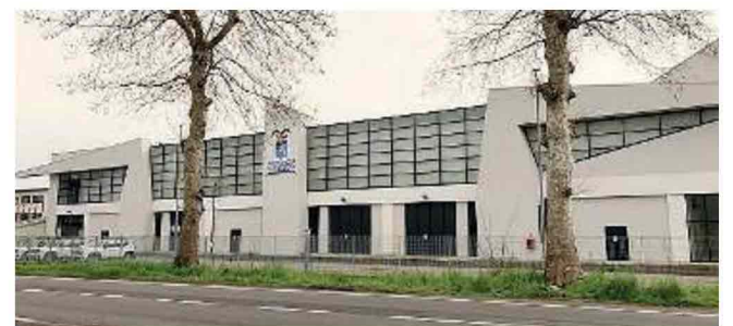
Da oltre un anno. La sede della Protezione civile provinciale, al palo
